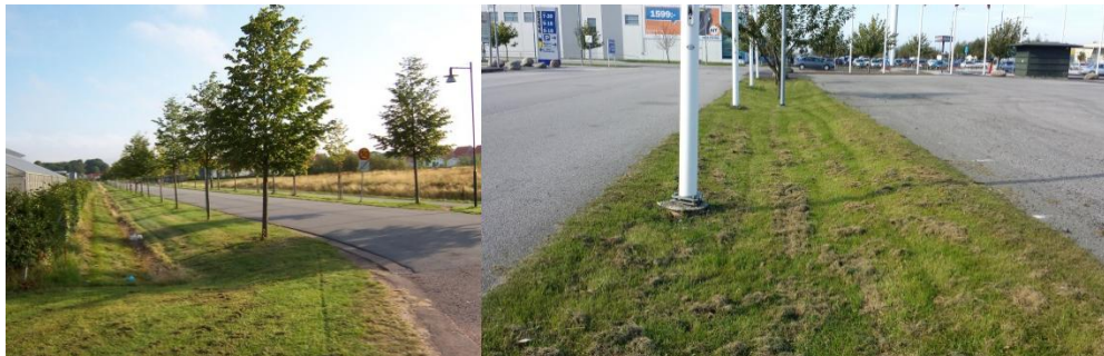
Figur 17. Exempel på utformning av svackdike; t.v. Mariastaden, Helsingborg (foto: Ramböll); t.h. Svågertorp, Malmö (foto: Ramböll).
